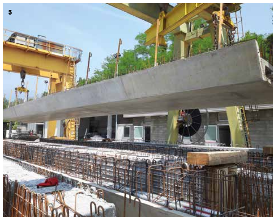
5. Movimentazioni travi dello stabilimento PAC
