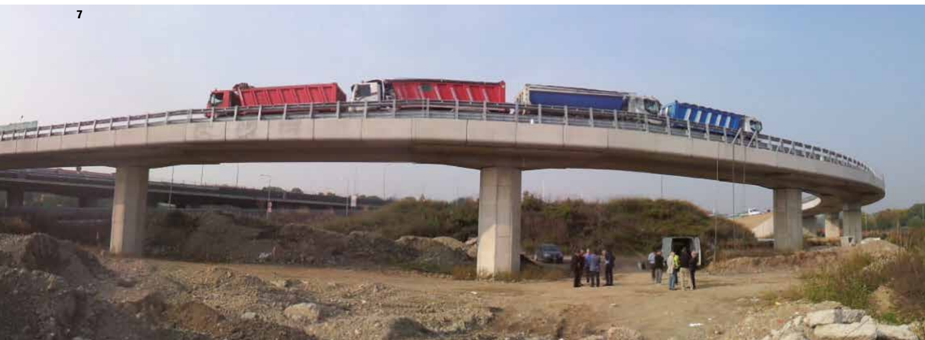
7. Prova di carico Rampa D, Tangenziale Est di Milano
