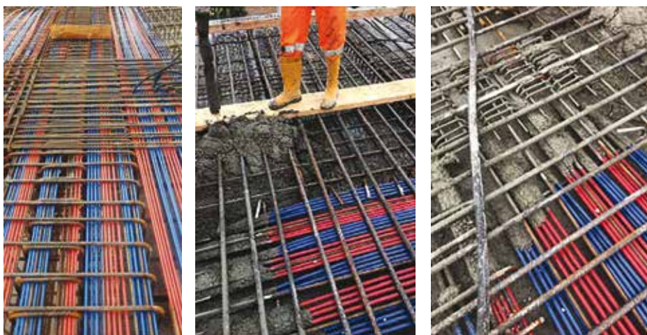
12A, 12B e 12C. La post-tensione con trefoli viplati
