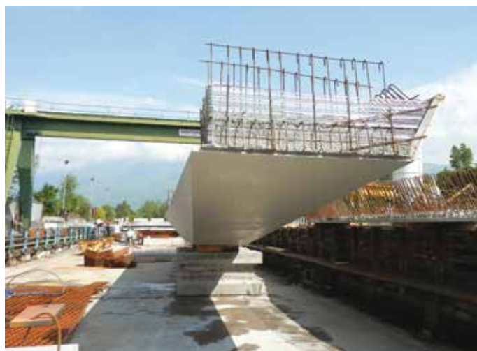
2. L'elemento a vasca realizzato in stabilimento per il getto in opera dei pulvini
