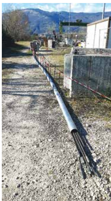
13A e 13B. Le prove di infilaggio per la post-tensione finale con cavi da 19 trefoli presso la sede PAC
