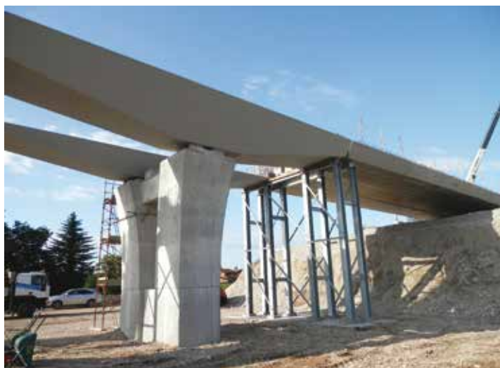
3A, 3B e 3C. La fase di montaggio dell'impalcato
