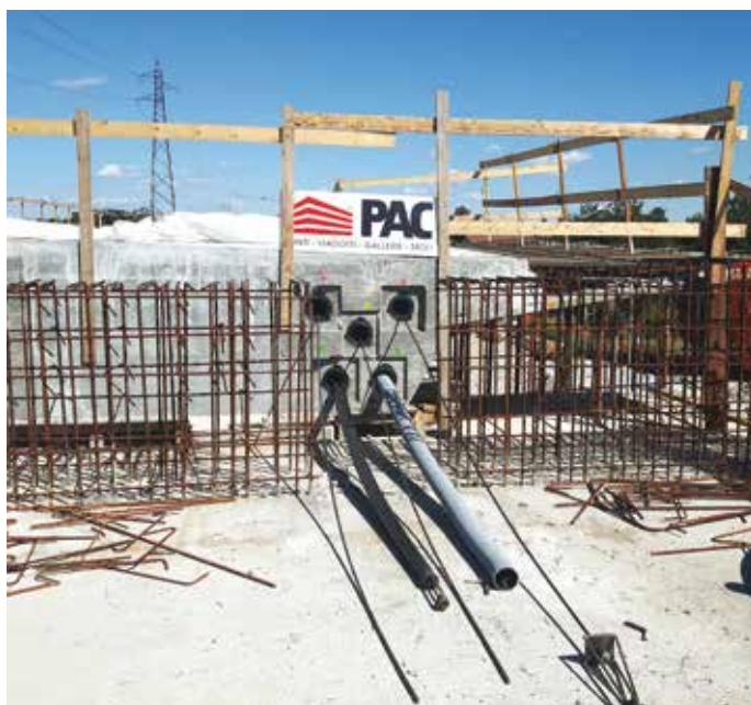
14. Il sistema di trascinamento dei cavi da 19 trefoli
